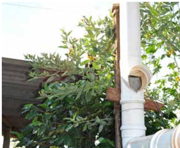
Filtro autolimpante instalado no Assentamento Bela Vista, em Iperó (SP)
