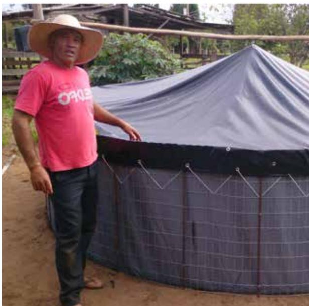
Esta é uma tecnologia simples, de baixo custo e adaptável a qualquer região. A água é captada das chuvas, por meio de calhas instaladas nos telhados das casas e outras construções e armazenadas em depósitos. Estes podem ser feitos de diversos materiais: alvenaria, plástico, metal e lona.
